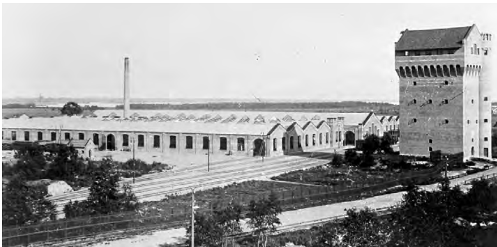
Vy över vagnverkstaden cirka 1908. CV:s vattentorn syns i förgrunden.
