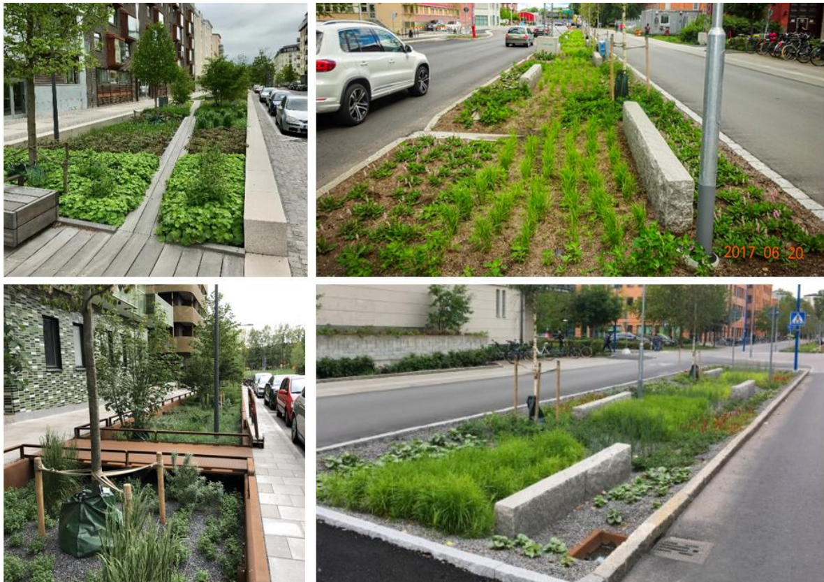
Figur 5-3. Biofilter/regnbäddar i gatumiljö. TV Norra Djurgårdsstaden, Stockholm (foto Structor). TH Strandbodgatan, Uppsala, två olika typer av inlopp, släpp i kantsten med erosionskydd längst upp (foto Bara mineraler) och genom inloppsbrunn med sandfångskar längst ner (foto Kent Fridell).
