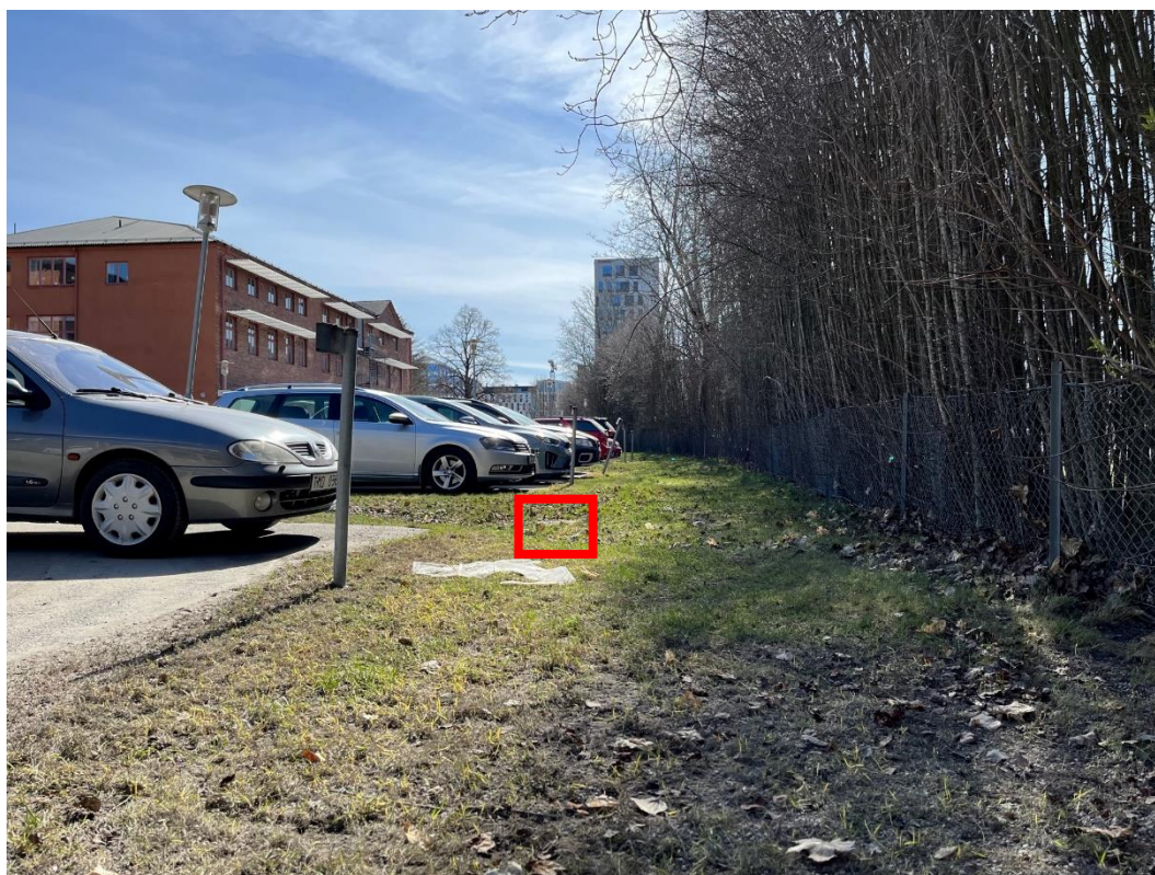
Figur 20 - Kupolbrunn (röd), västra delen i Kexfabriken 3 (Platsbesök 2023-04-20).
