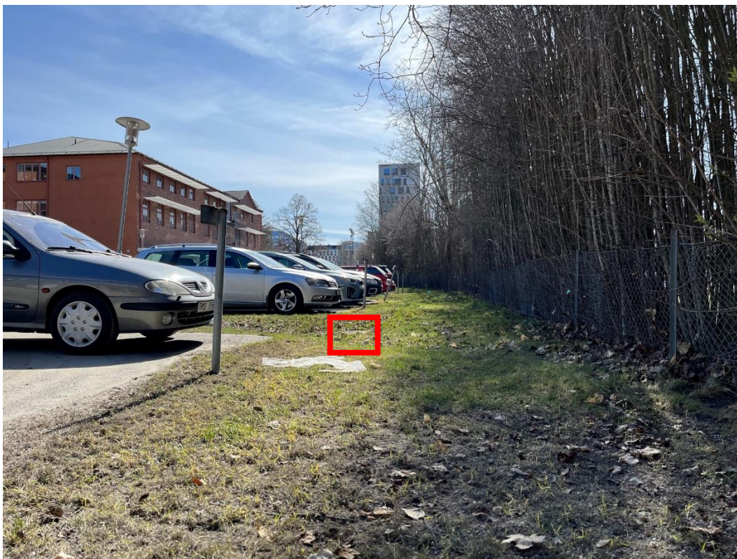
Figur 20 - Kupolbrunn (röd), västra delen i Kexfabriken 3 (Platsbesök 2023-04-20).
