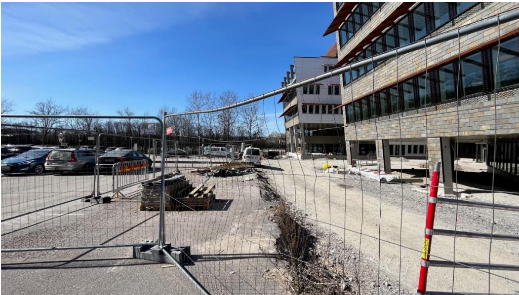
Figur 7 - Höjdskillnad mellan Kexfabriken 3 (vänster) och 2 (höger) (Källa: Platsbesök 2023-04-20).
