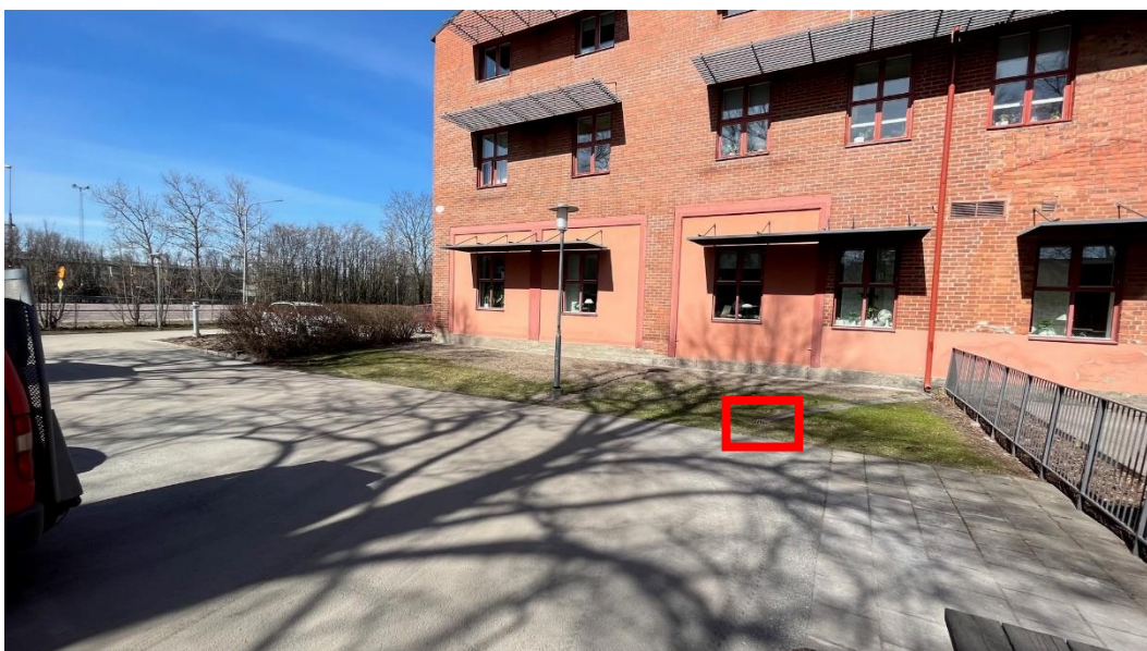
Figur 21 - Kupolbrunn (röd), södra delen i Kexfabriken 3 (Platsbesök 2023-04-20).
