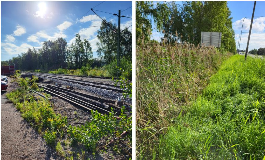
Figur 25. Till vänster: Järnvägsspår norr om Södra infartsleden (i drift). Till höger: grönyta mellan järnväg och Södra infartsleden.
