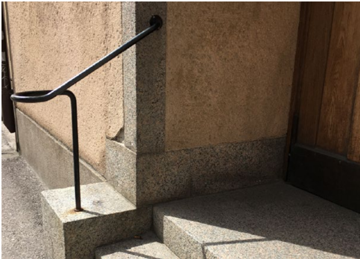
Vid kyrkans entré finns ursprungliga material som trappsteg i granit och räcke i svartmålat smide.
