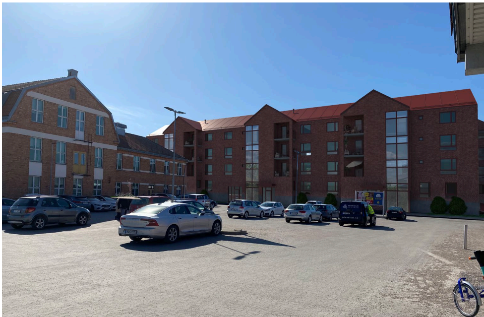
Bilden ovan visar bebyggelseförslaget sett från norr. Illustrationen är framtagen av PE Teknik & Arkitektur.
