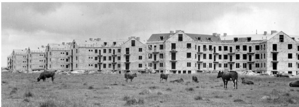
Rosta Stjärnhus under uppbyggnad.
